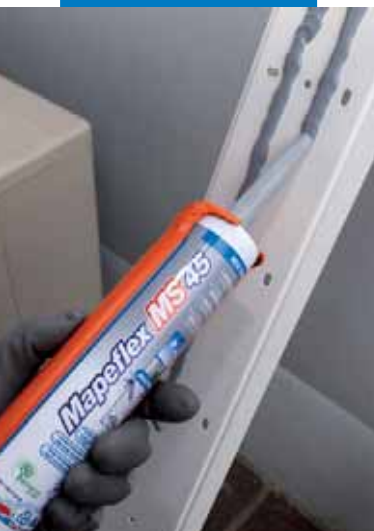
Lepení plastových profilů v exteriéru
