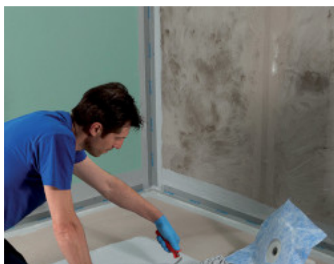
Instalace tvarovky Drain Vertical s použitím Mapegumu WPS
