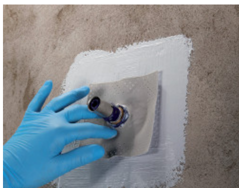
Instalace manžety Mapeband PE 120 na utěsnění prostupu potrubí s použitím Mapegumu WPS
