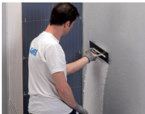
Lepení obkladu s použitím lepidla Keraflex Maxi S1
