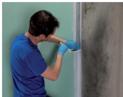
Instalace pásu Mapeband PE 120 lepeného výrobkem Mapegum WPS
