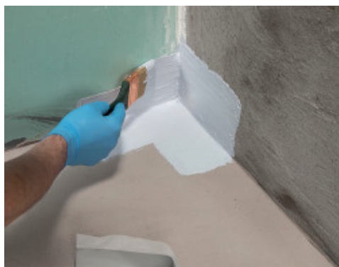
Instalace rohové tvarovky 90° Mapebandu PE 120 lepeně výrobkem Mapegum WPS
