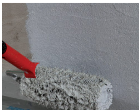
Aplikace hydroizolační stěrky Mapegum WPS válečkem
